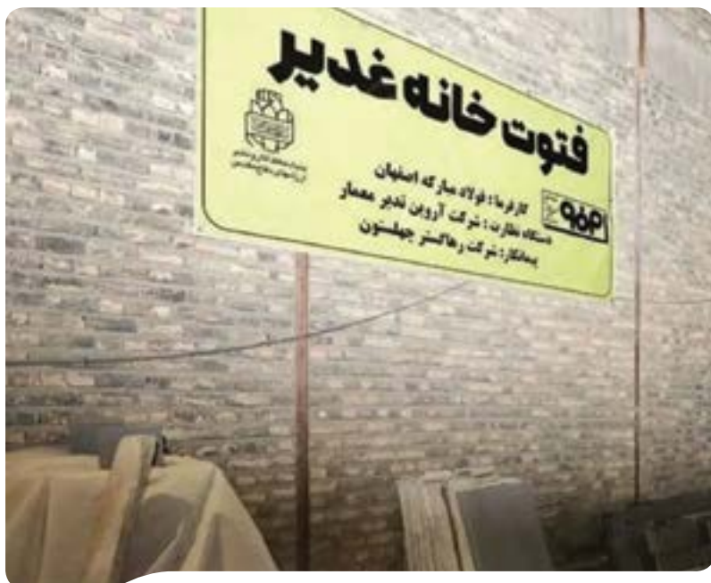
عملیات احداث فتوت‌خانه غدیر
