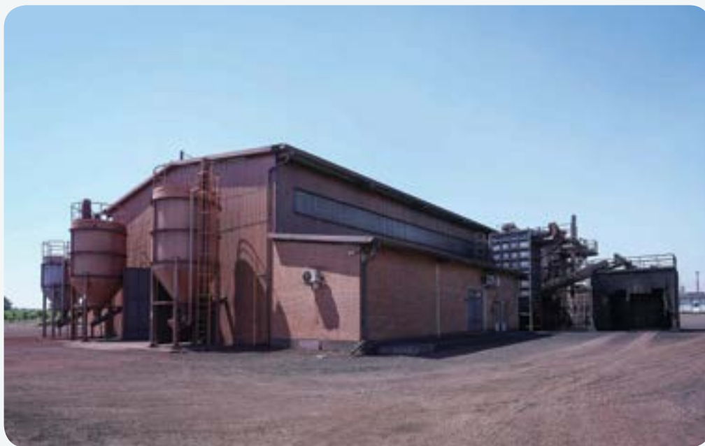
کارخانه فرآوری لجن و پودرهای اکسیدی در شرکت فولاد مبارکه
