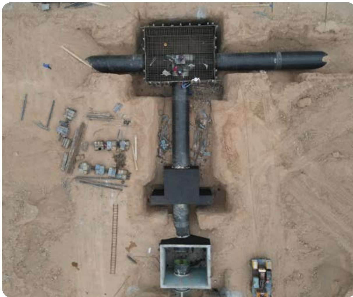
احداث خط لوله انتقال آب از دریای عمان
