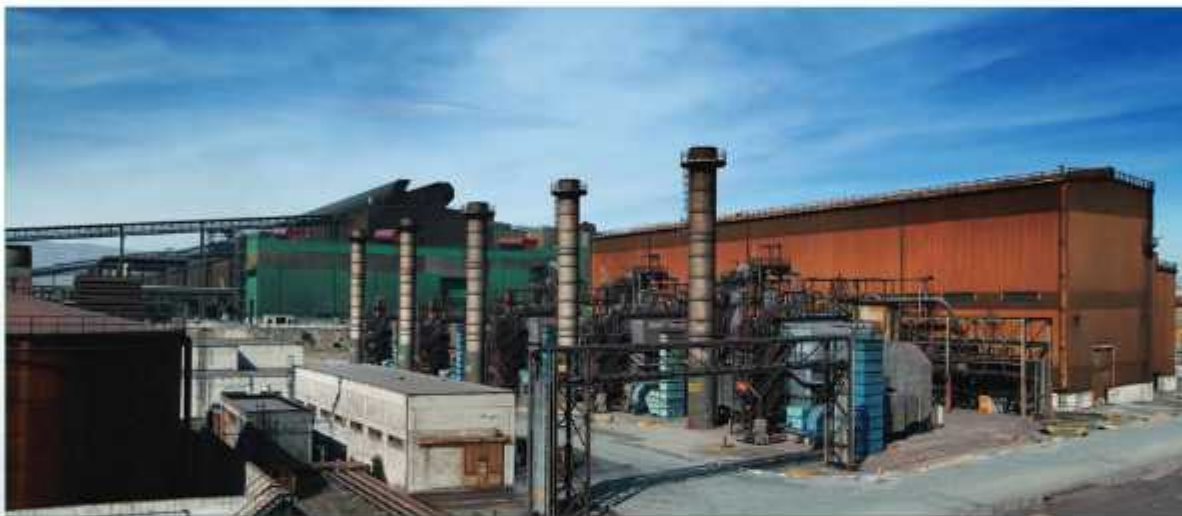
نیروگاه فولاد مبارکه
