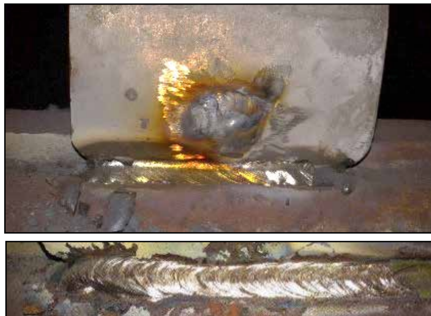
شکل ۶. خط جوش مربوط به اتصال رایدِر به بیم
